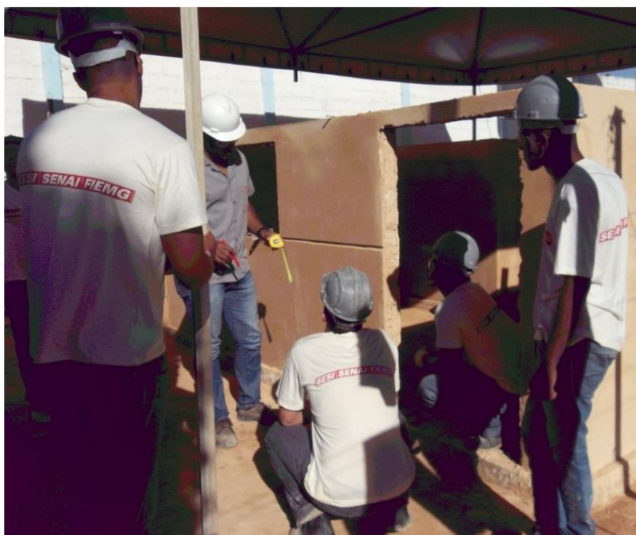
Curso de pedreiro de alvenaria – APAC de Patrocínio
