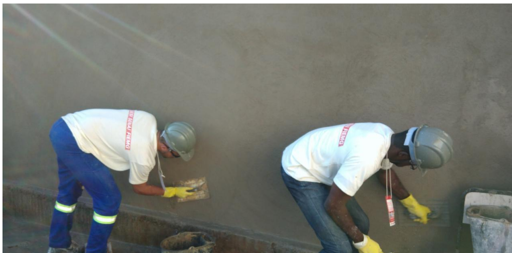
Curso de pedreiro de alvenaria – APAC de Santa Bárbara
